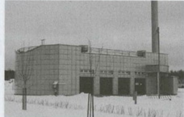
Мощности небольшой котельной с 3 котлами по 3 МВт каждый Брестского ГСКБ хватает для нужд всего комплекса.
