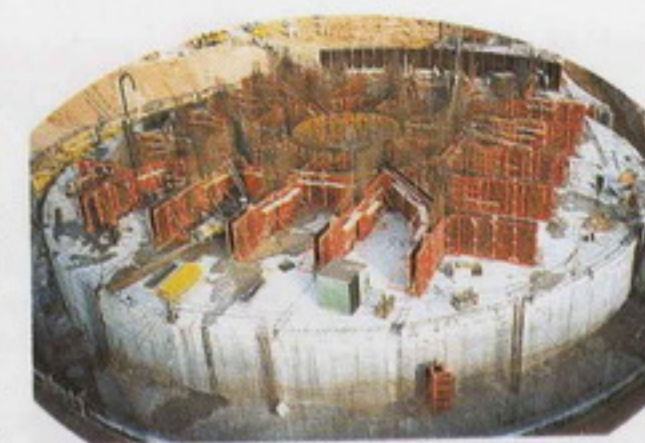
Рис. 3. Возведение монолитных стен подвала
