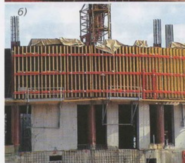
Рис. 6. Схема опалубки криволинейной монолитной стены на отм. +4,200: а — установка проемообразователей; б — монтаж наружной панели опалубки
