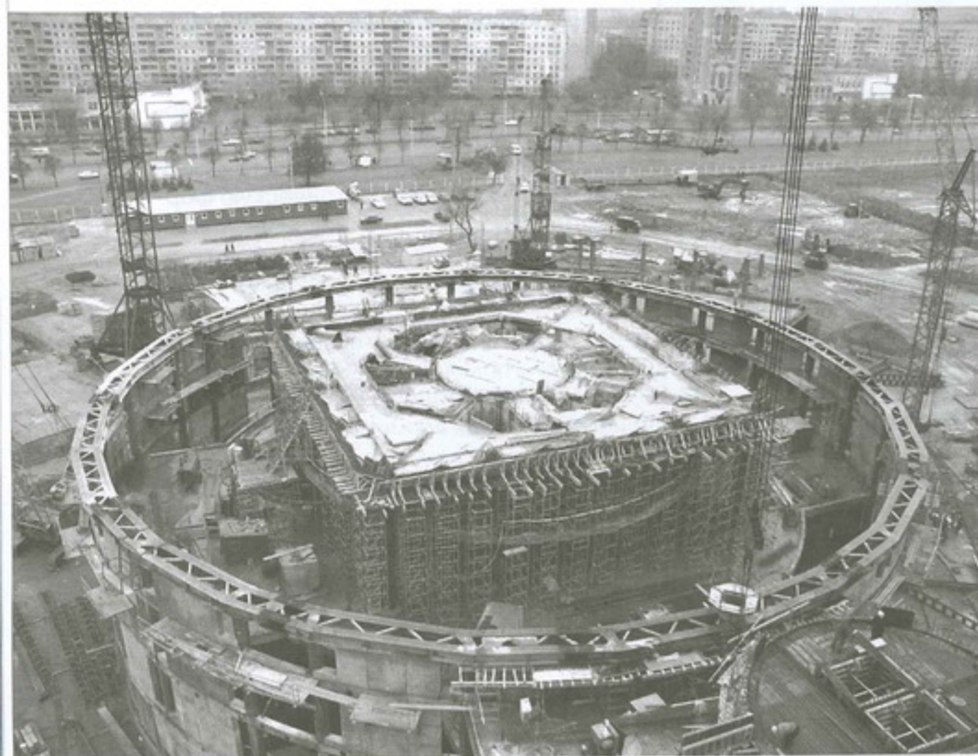
Рис. 4. Опорное кольцо на отметке 12,6 м перед бетонированием
