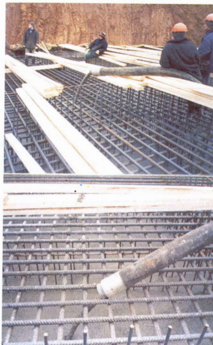
Рисунок 6. Бетонирование нижней фундаментной плиты НБ при помощи бетононасоса (20-22 января 2003 г.)
