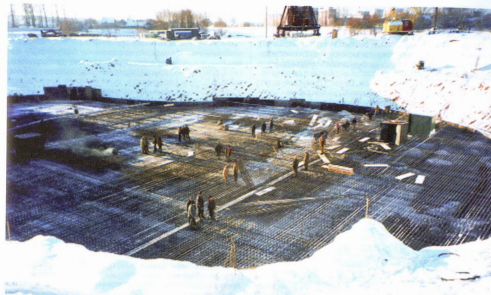
Рисунок 1. Армирование нижней фундаментной плиты (январь 2003)
