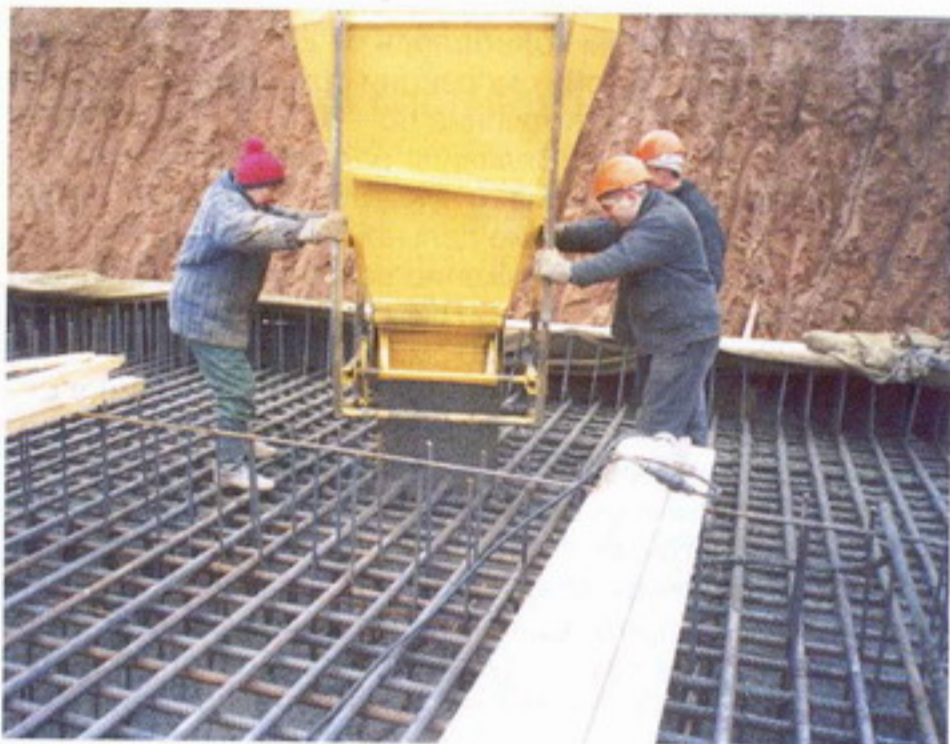
Рисунок 5. Бетонирование нижней фундаментной плиты при помощи бадей типа БП-1,0 краном типа КБ-674
