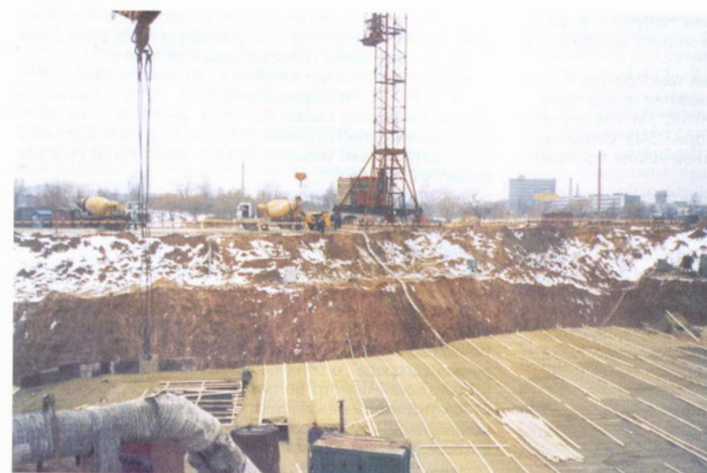
Рисунок 7. Выдерживание бетона класса В25 W6 F100 нижней фундаментной плиты методом "термоса" с добетонированием отдельных участков плиты бетононасосом (на дальнем плане)
