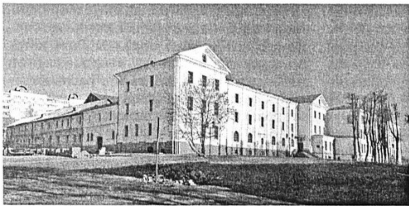
Здание Полоцкого иезуитского коллегиума
