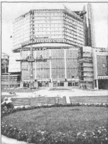
саде задействованы "Белбытстрой" и "Rann building": первая проводит изоляцию стен высотного книгохранилища, вторая устанавливает алюминиевые панели под стекло. Как только остекление будет закончено, СМУ-77 приступит к монтажу многочисленных металлоконструкций, опоясывающих здание. Его специалистам предстоит серь-
