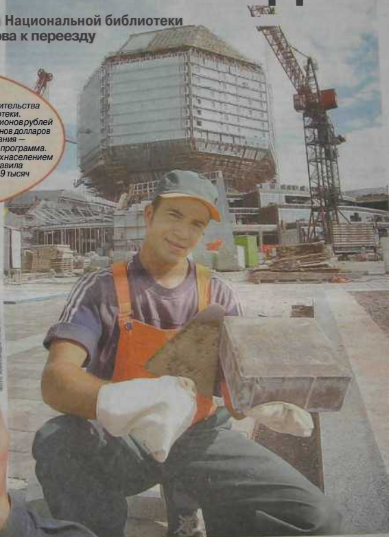
На снимках: завершающий этап строительства Национальной библиотеки. Строительщик Игорь БУРАК; каменщик Константин МИСЛЕВИЧ.
