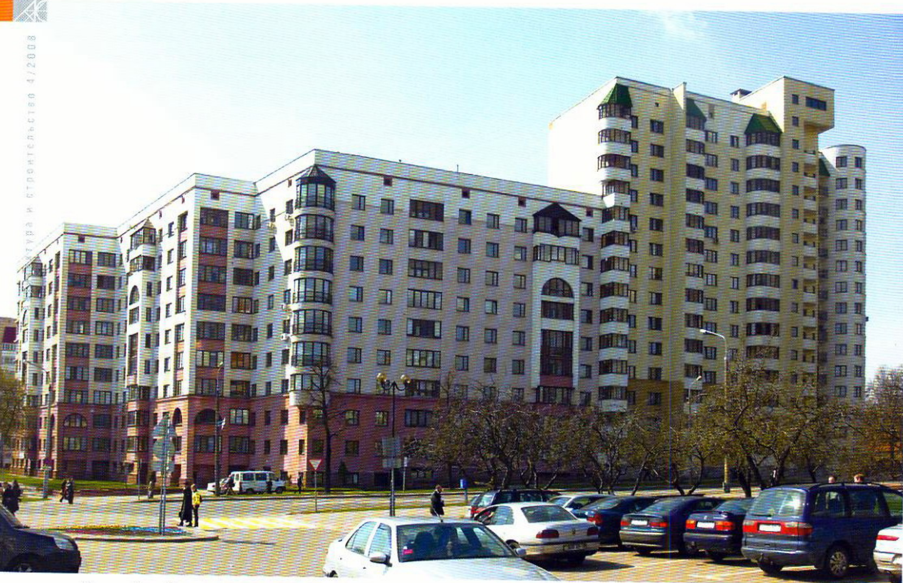
14-этажный жилой дом на перекрестке улиц Первомайская – Захарова
