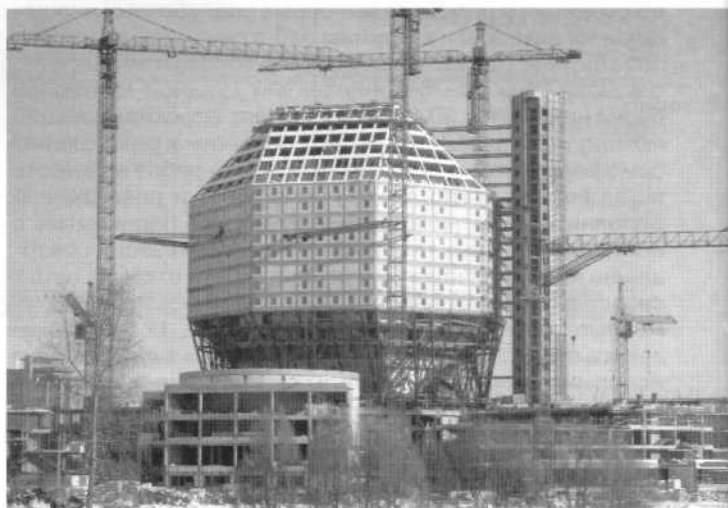
Рисунок 14. Общий вид монолитного каркаса
