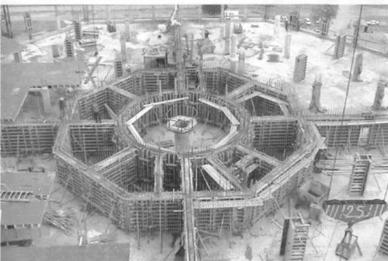
Рисунок 11. Опалубка ядра и диафрагм жесткости типового этажа
