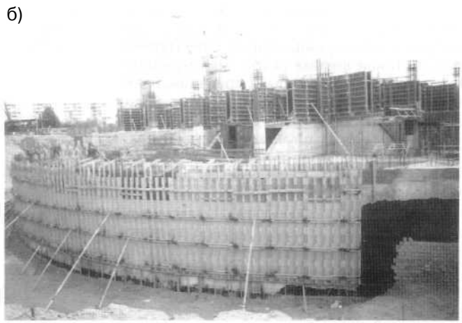
Рисунок 1. Возведение монолитных стен подвала:
