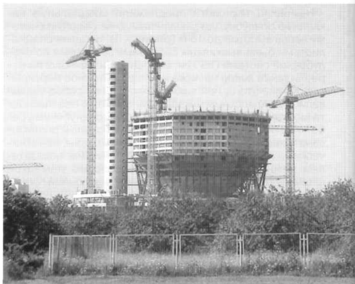
Рисунок 12. Строительство типовых этажей
