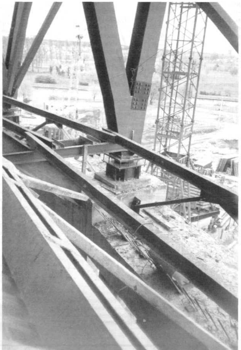
Рисунок 14. Общий вид смонтированного песчаного домкрата и поддерживающих опор
