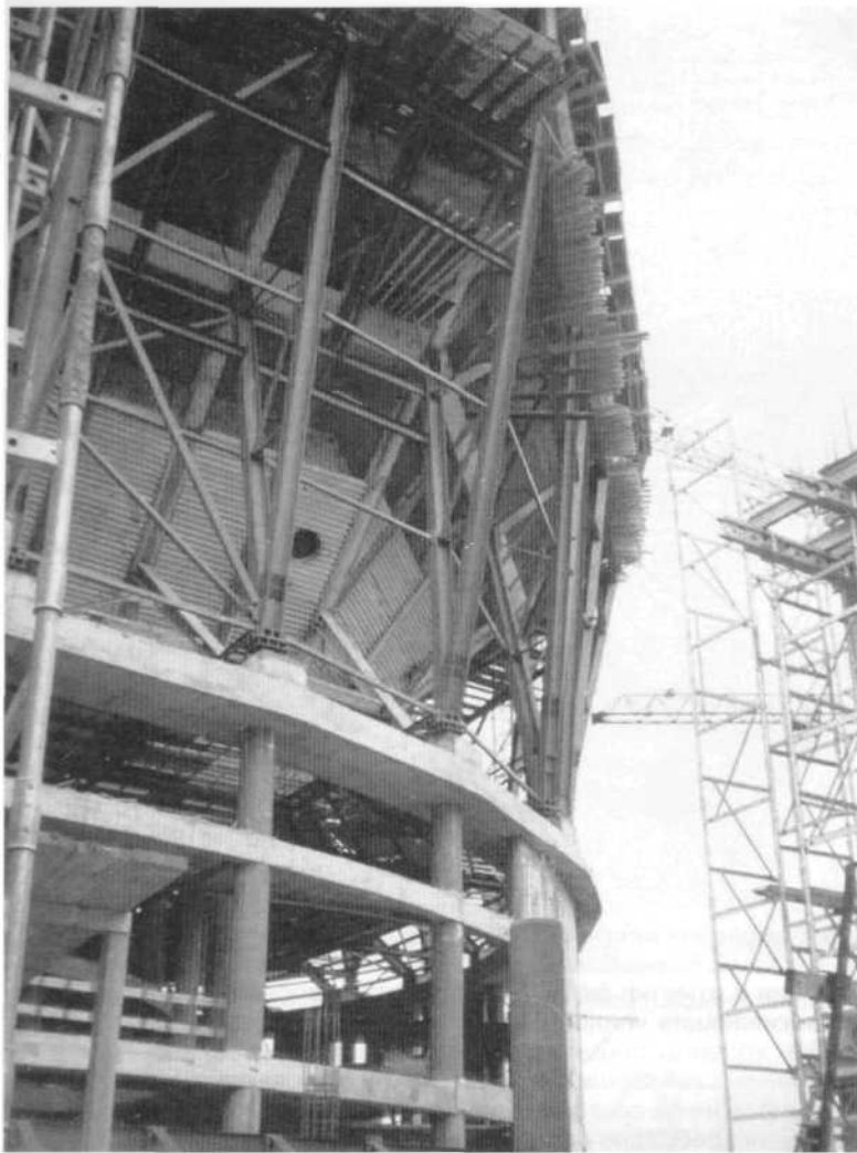
Рисунок 4. Опорное кольцо после замоноличивания и система поддерживающих опор
