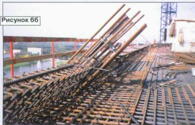
Рисунок 6. Узлы сопряжения металлических колонн с железобетонными: а — вертикальные колонны безбалочного перекрытия (узел "Б", рисунок 9); б — наклонные колонны наружного контура здания (узел "А", рисунок 9)
