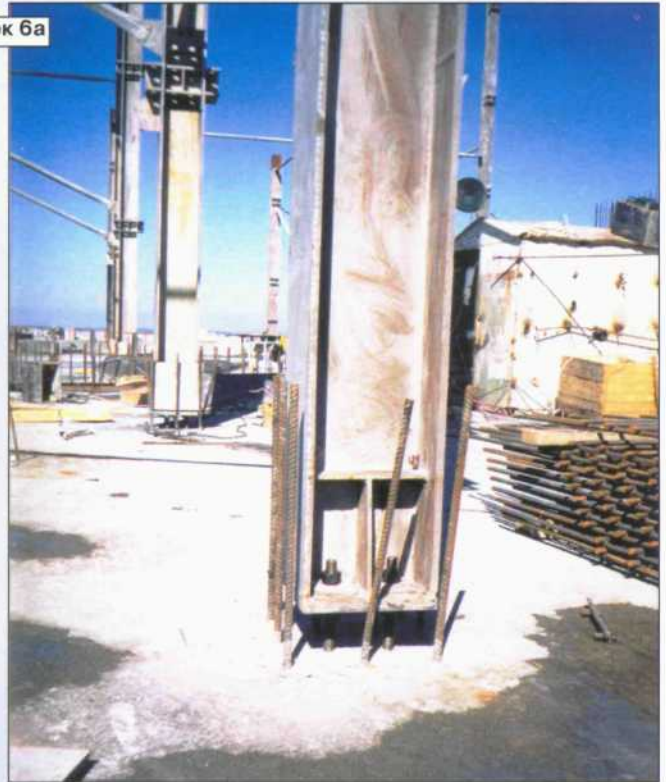
Рисунок 6. Узлы сопряжения металлических колонн с железобетонными: а — вертикальные колонны безбалочного перекрытия (узел "Б", рисунок 9); б — наклонные колонны наружного контура здания (узел "А", рисунок 9)
