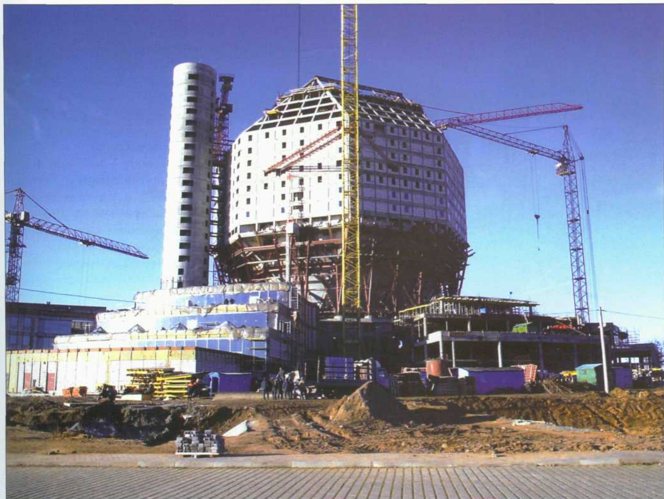
Рисунок 2. Общий вид возведения здания книгохранилища на отметке 66,9 м
