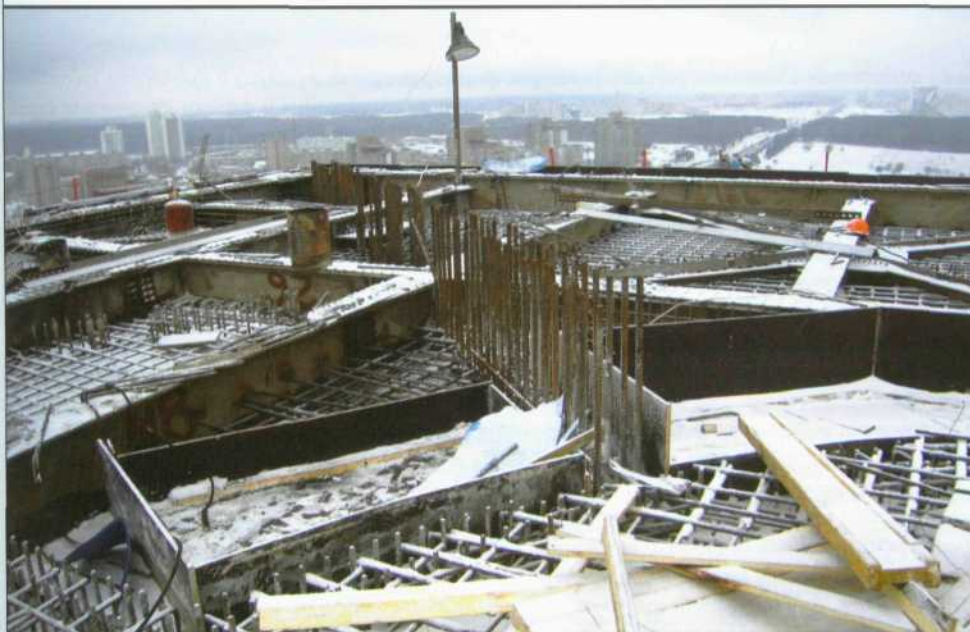
Рисунок 12. Фрагмент сталежелезобетонного покрытия пространственного каркаса ромбокубооктаэдра на отметке 72,6 м
