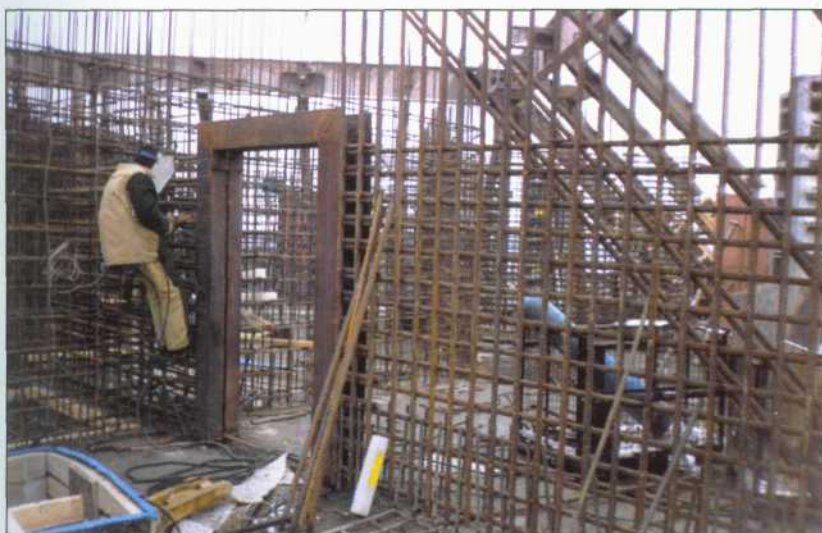
Рисунок 10. Армирование короткой диафрагмы жесткости на отметке 66,6 м
