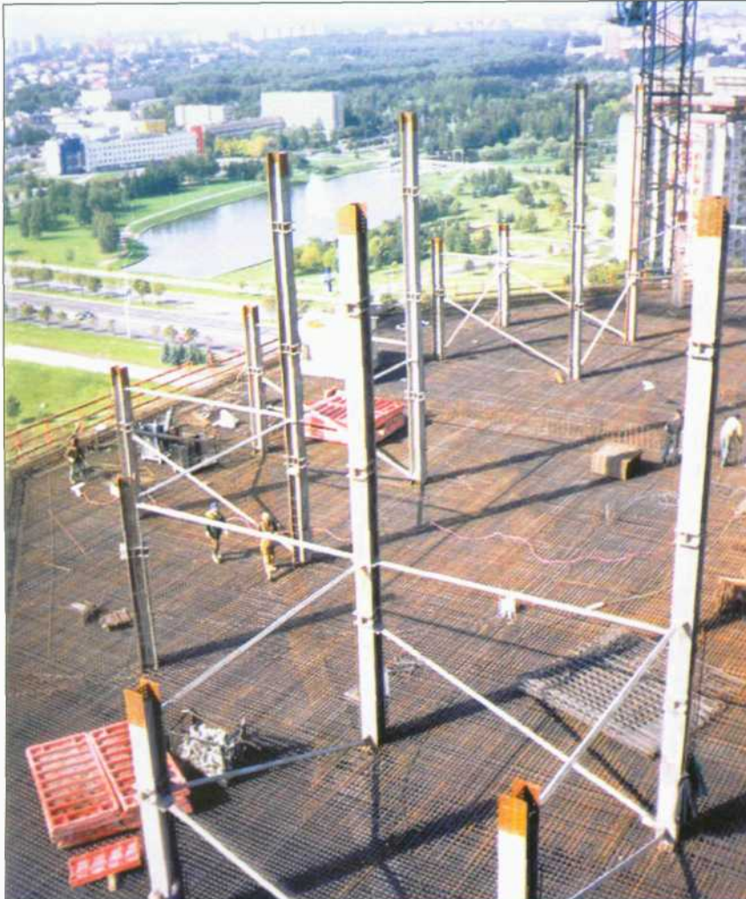
Рисунок 4. Монтаж металлических колонн на отметке 54,6 м
