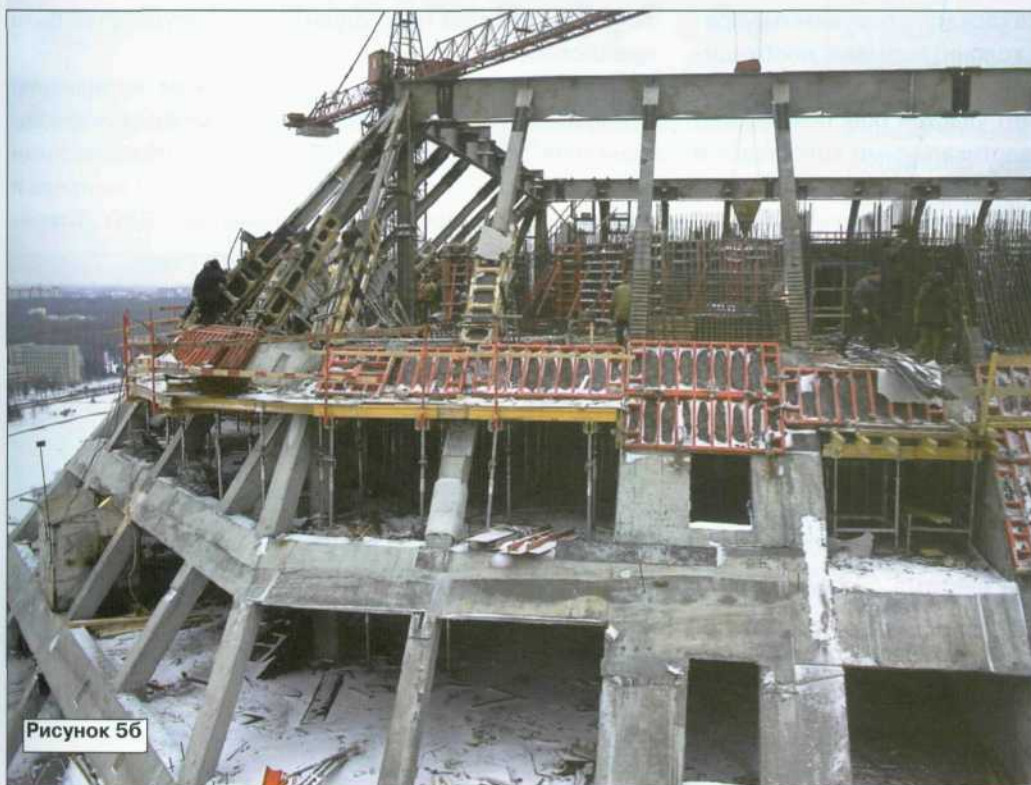
Рисунок 5. Общий вид металлического каркаса: а — на отметке 72,6 м; б — обетонированные металлические колонны каркаса в подвесной опалубке
