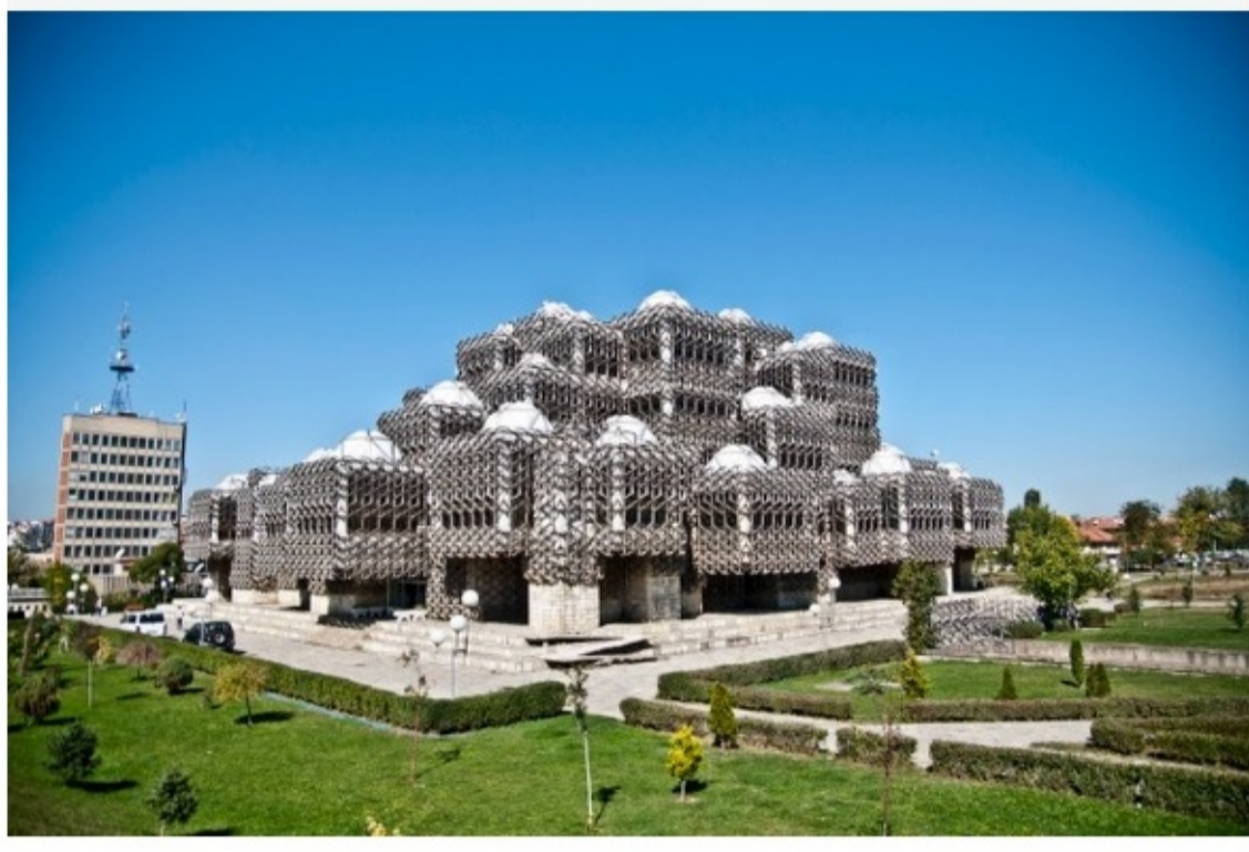
Строительство закончилось в 1982 году / Фото Archdaily
