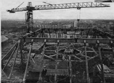
Узел сопряжения стоек кружая с песчаными домкратами и опорным кольцом
