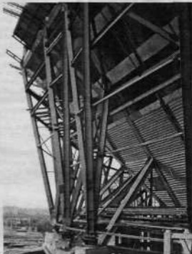
Узел сопряжения стоек кружая с песчаными домкратами и опорным кольцом
