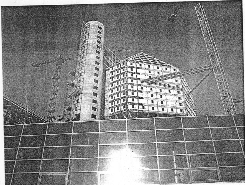
На строительстве Национальной библиотеки Беларусь уже закончена сложнейшая работа по раскружиливанию — сняты 28 домкратов, поддерживавших здание, завершается демонтаж временных металлоконструкций.
