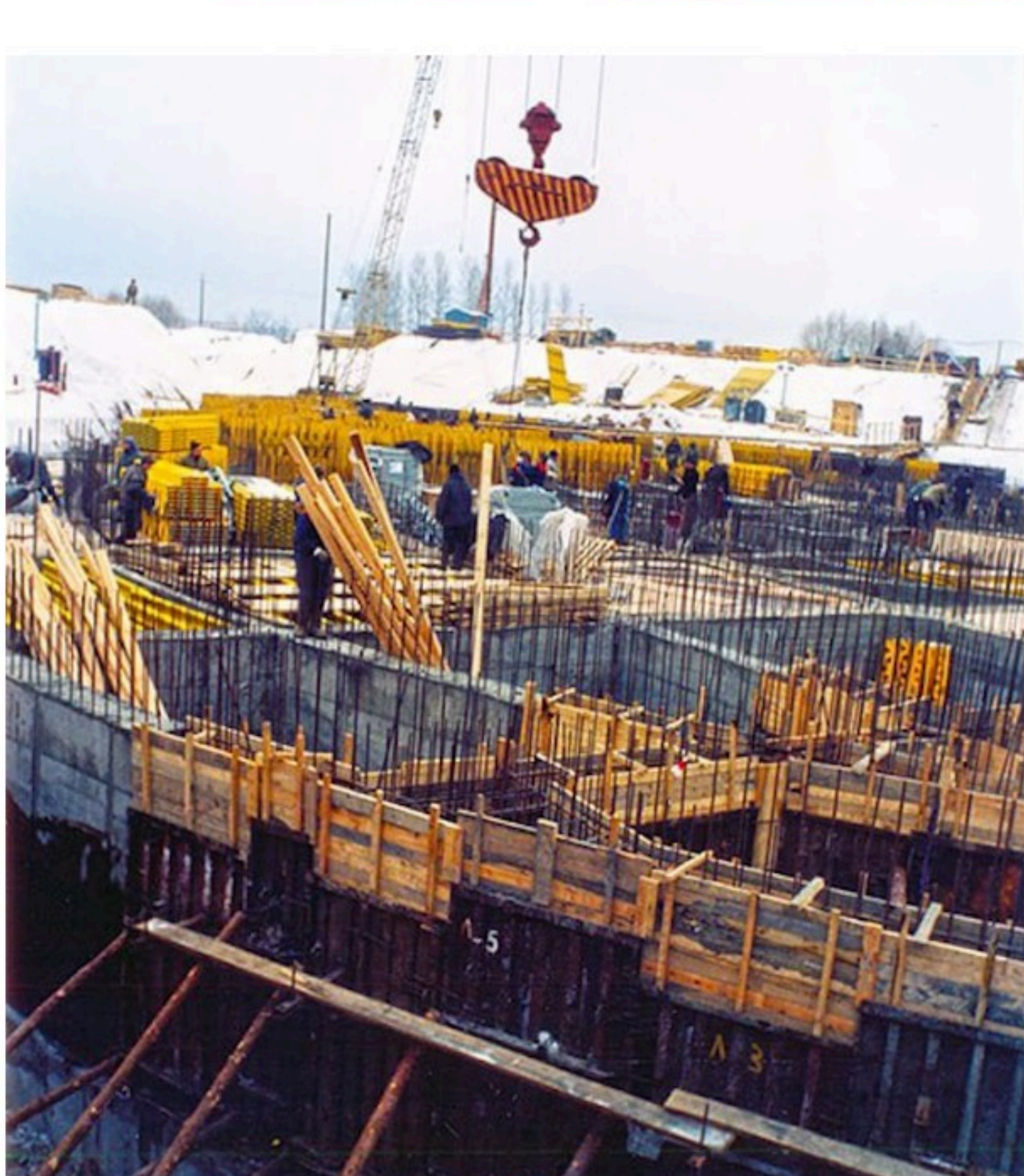
Устройство тепляка для защиты бетона от отрицательных температур. Ноябрь 2002 г.
