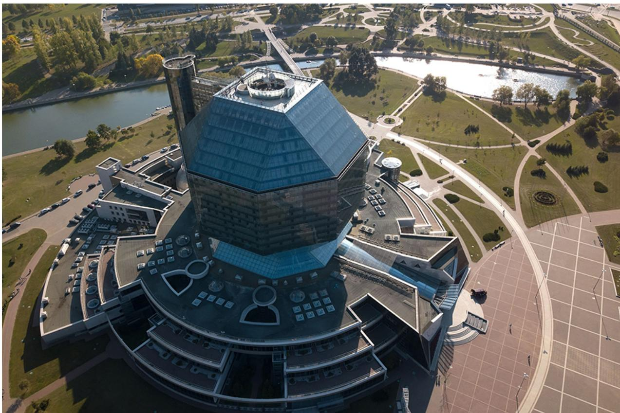
Здание НББ — это ромбокубооктаэдр высотой 73,7 м (23 этажа) и весом 115 000 тонн (не считая книг). Общая площадь здания — 113,7 тыс. м<sup>2</sup>, в том числе книгохранилища — 54,9 тыс. м<sup>2</sup>. Здание оборудовано автоматизированной системой доставки литературы «Телелифт», состоящей из монорельсов и контейнеров грузоподъемностью от 5 до 10 кг. Фото [БЕЛТА](#)
